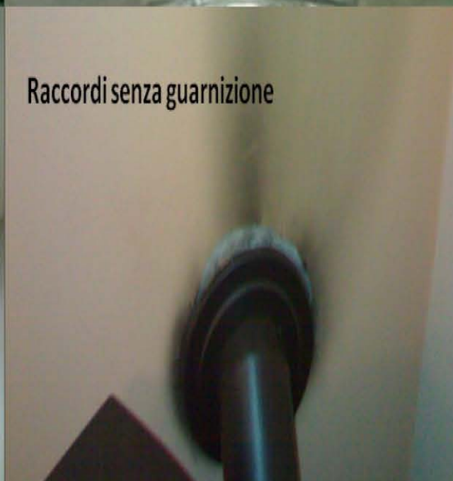
Raccordo camino canna fatto con silicone curve create dall'unione di tanti tronchetti di tubo
