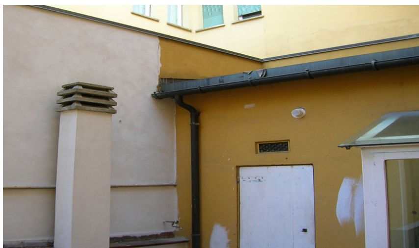
Fig. 4 - Scarico del generatore sul terrazzo di un'unità abitativa
