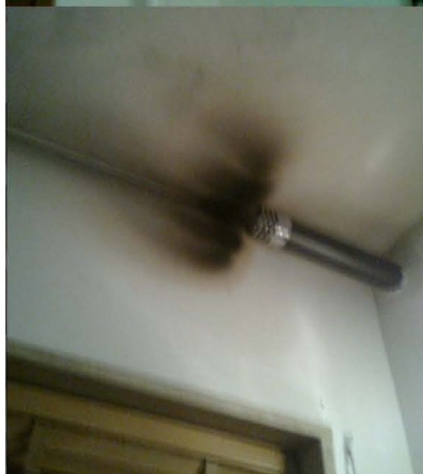
Raccordi senza guarnizione
