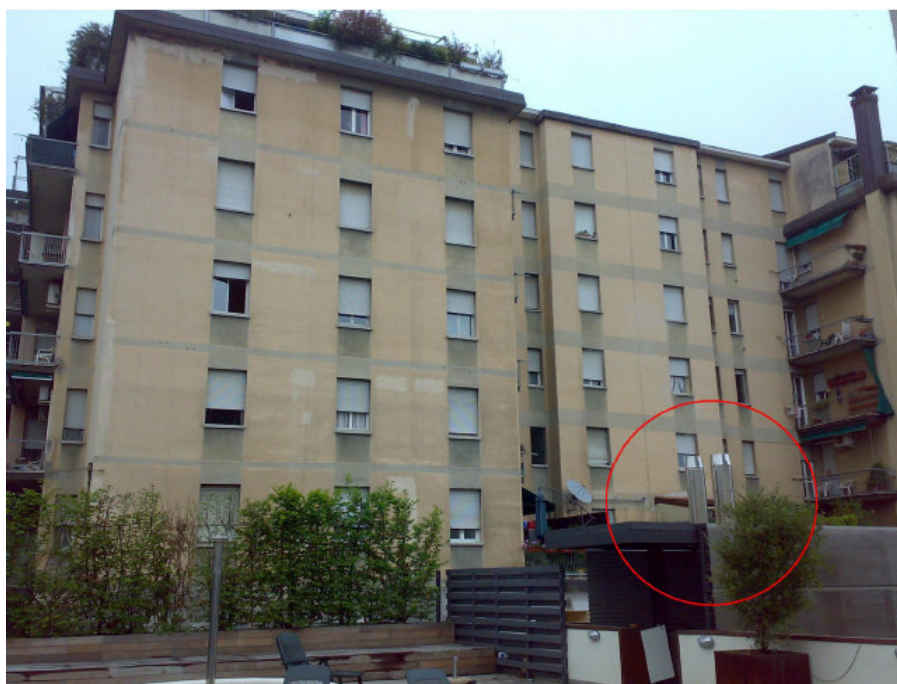
Fig. 6 - Camini di un impianto termico centralizzato
