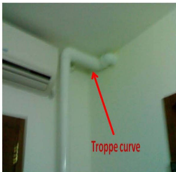
Raccordo camino canna fatto con silicone curve create dall'unione di tanti tronchetti di tubo
