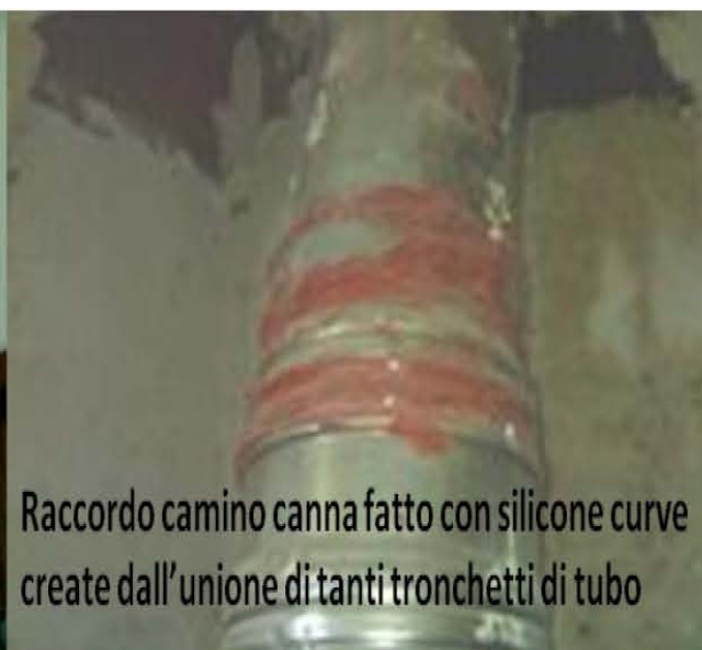
Raccordi senza guarnizione
