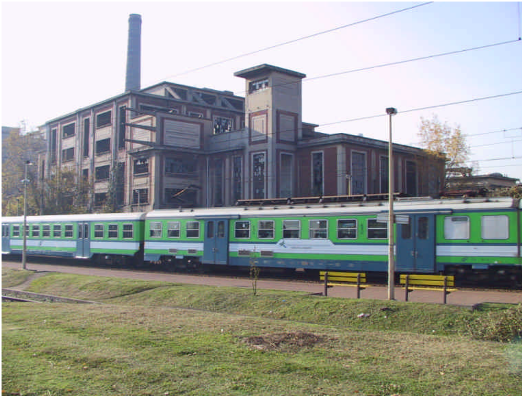
Figura 7 Il prospetto lungo la ferrovia
