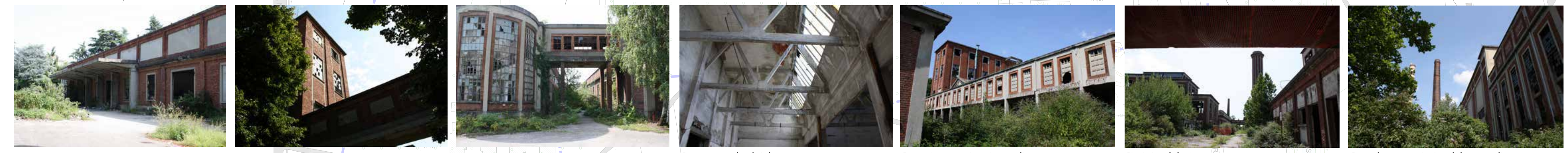
Copertura aggettante primo blocco per carico e scarico Torre con collegamento sopraelevato passaggio impianti perimetrale Corpo centrale della facciata edifici industriali Struttura a shed rialzata Camminamenti perimetrali per impianti e timpano delle precedenti edificazioni Ciminiera del 1947 Complesso costituito dal corpo di fabbrica della centrale elettrica e prima ciminiera edificata
