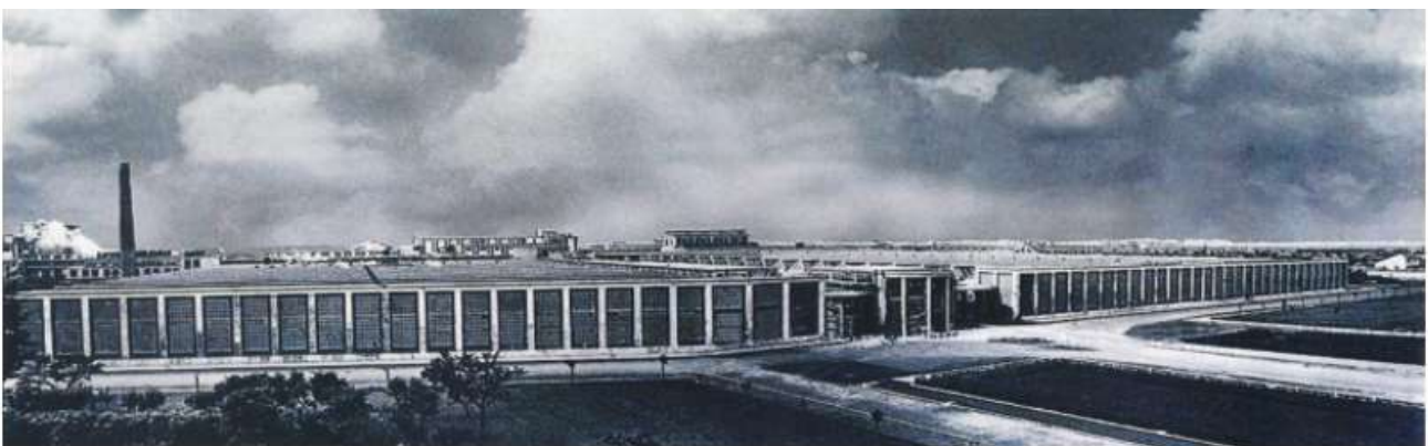
La facciata principale dello stabilimento nel 1952 (fonte: Sniaviscosavaredo.it)
