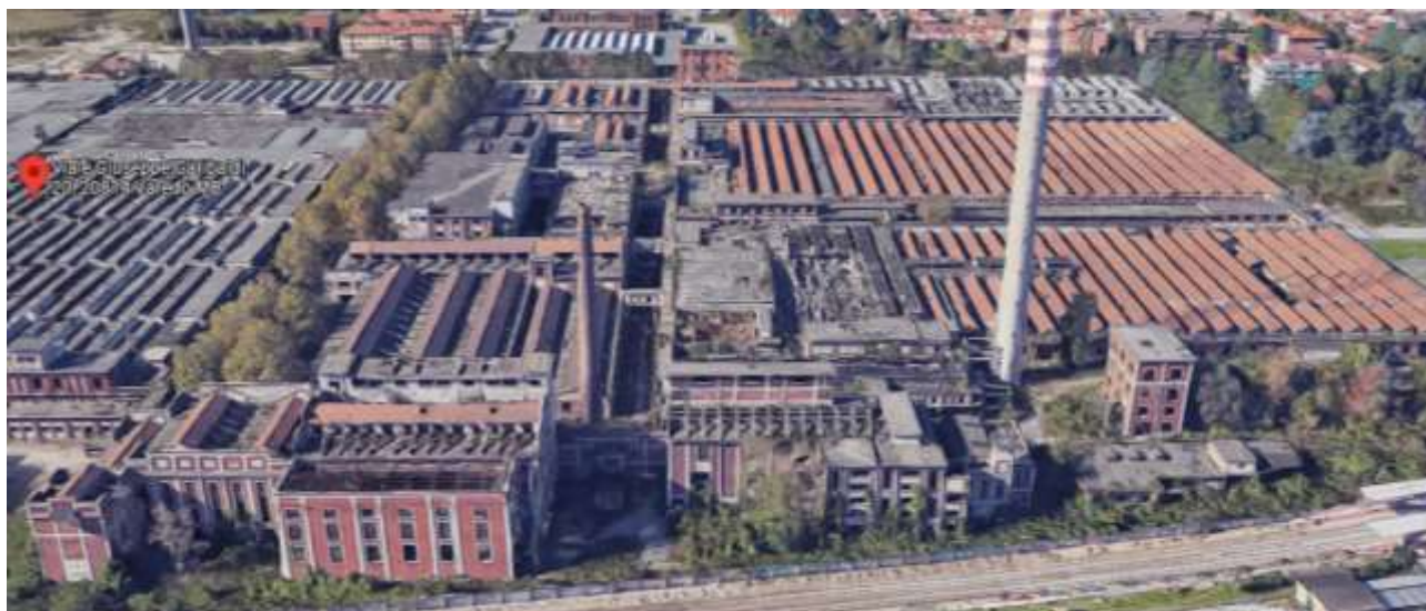
Vista aerea di potenziali elementi superstiti dell'impianto originale del 1937 (fonte: Google Maps)
