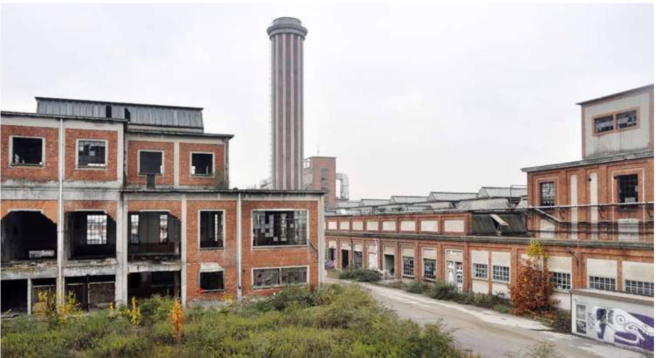
Ciminiera della produzione rayon continuo ed edificio della disidratazione solfato sodico (st-al.com)
