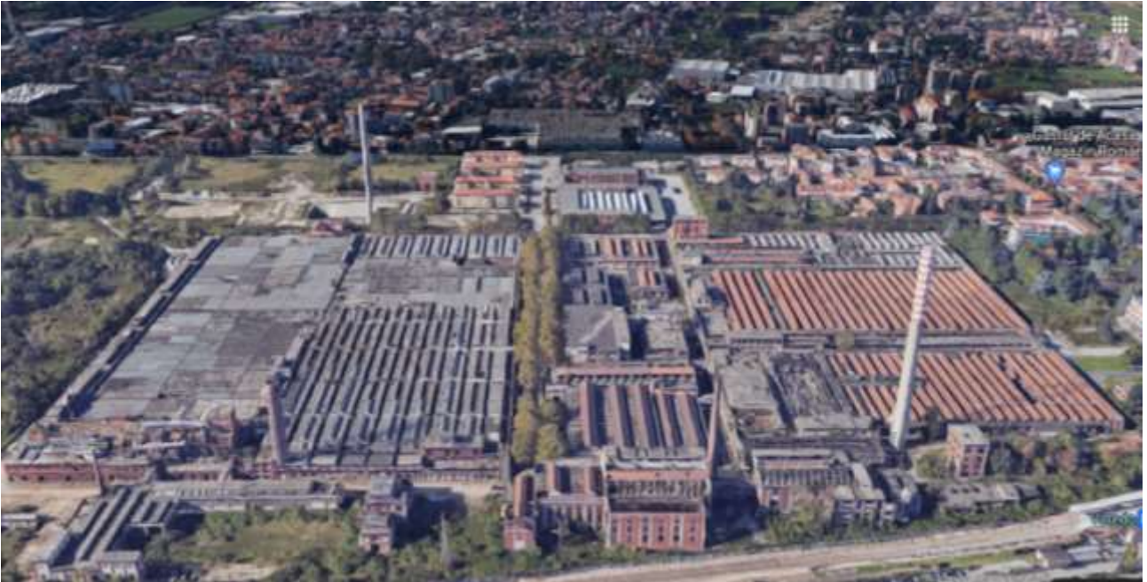
Le 5 ciminiere esistenti all'interno del comparto Snia di Varedo (fonte: Google Maps)
