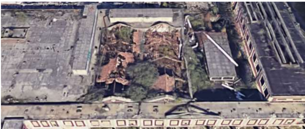
Vista aerea di potenziali elementi superstiti dell'impianto originale del 1925 (fonte: Google Maps)
