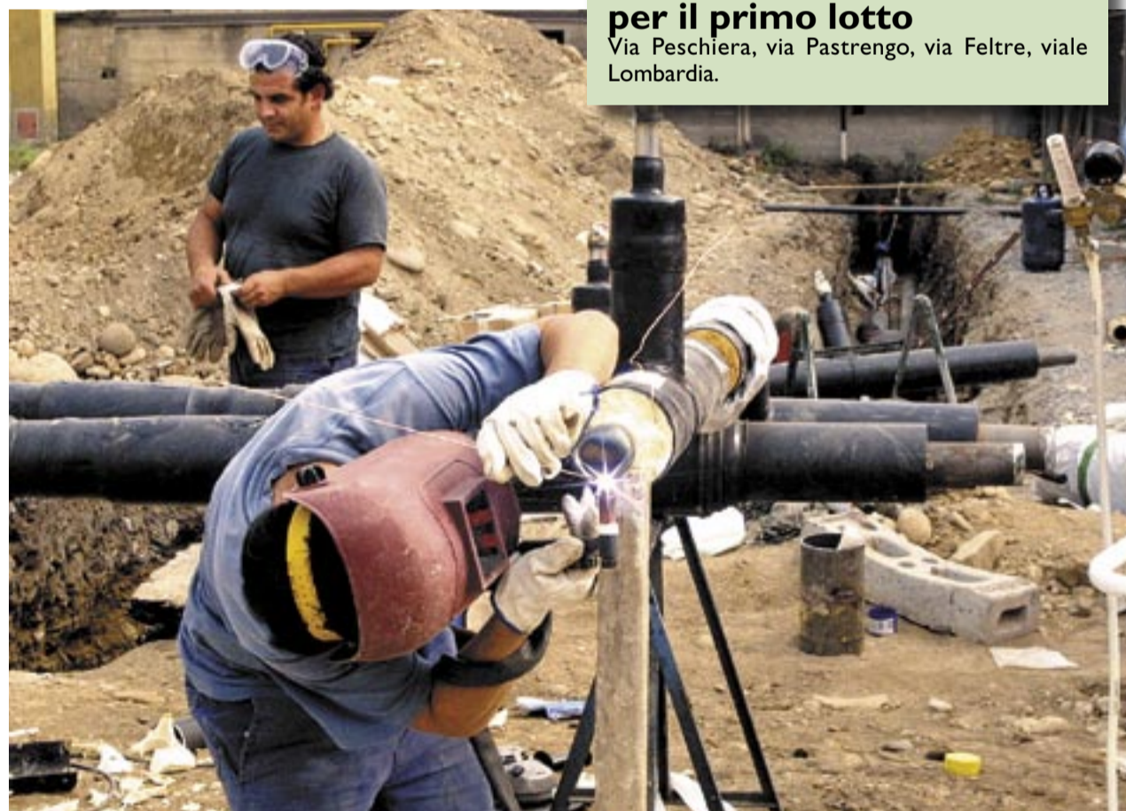
I lavori per la realizzazione del progetto teleriscaldamento
